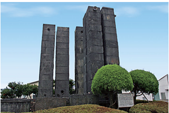
図3 『ルブラン法炭酸ソーダ製造装置塩酸吸収塔』 (No.004 日産化学(株)蔵、高さ約10m)
