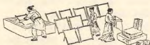
中国漢代製紙工程図 (潘吉星『中国製紙技術史』邦訳版)
