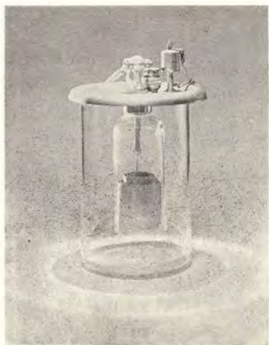
図8 Döbereiner 水素燈 〔『化学と工業』34(10) (昭56)〕
